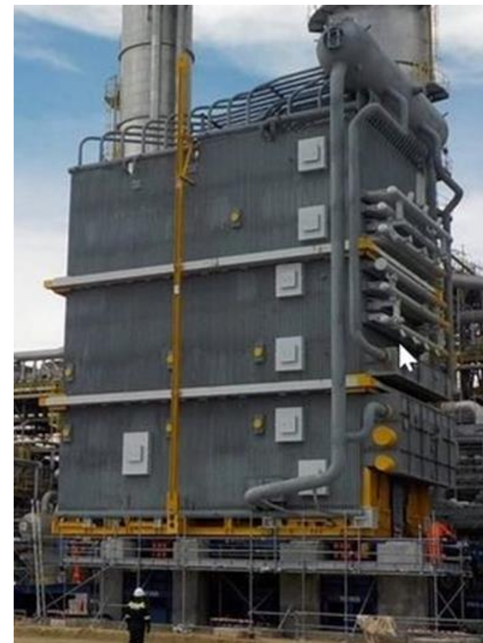
خواهد گرفت. آب ورودی توسط دان‌کامرها به سمت پایین حرکت کرده و پس از جذب گرما از طریق تیوب‌ها، به منظور جدایش بخار به درام یادشده باز می‌گردد. خانواده بویلرهای تک‌درام قادرند بخارهای با فشارهای بسیار بالا را تولید نمایند (شکل ۱).
