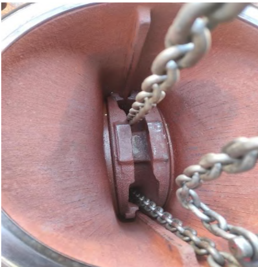
گیر کردن گیت داخلی شیر
