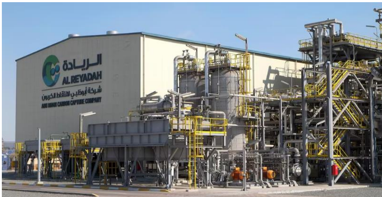
شکل ۱. پلنت جذب کربن اجرا شده برای فولاد ارکان امارات
